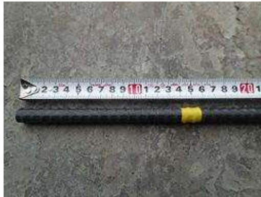
写真 4-5 アンカー筋へのマーキング(埋込み長さの位置)
