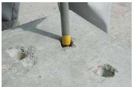
写真 4-22 ノズルマークによる注入量確認
