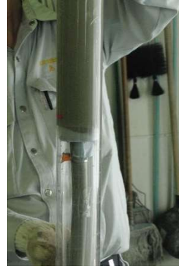
上向きも同様に施工
