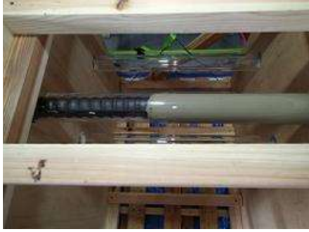
アンカー筋挿入
