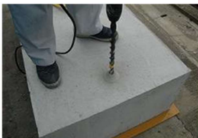
写真 4-1 穿孔(ハンマードリル)
