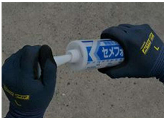
写真 4-9 コーンノズルによる開封
