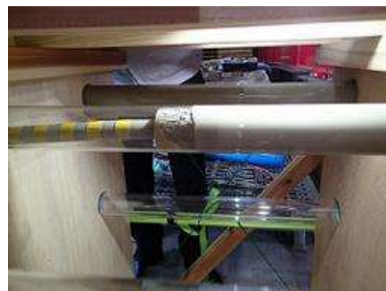
孔奥より手前に引いてセメフォースアンカーを注入
