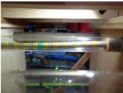
先端処理したホースで孔奥まで挿入、注入
