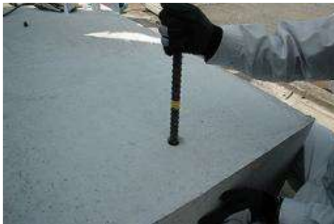
写真 4-23 アンカー筋の埋め込み
