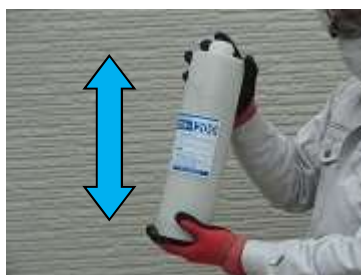
写真 4-8 セメフォースアンカーの空振り (上から順に、セメフォースアンカー150、500、1200)
