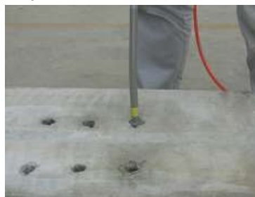
写真 4-22 ノズルマークによる注入量確認
