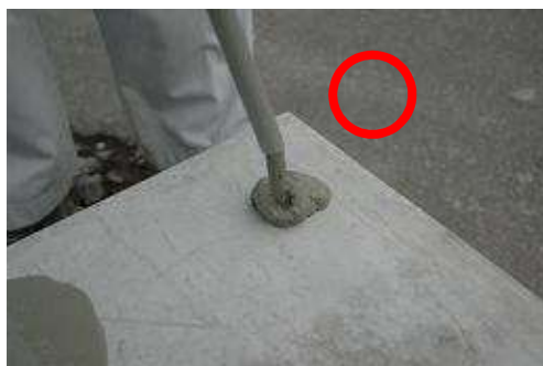
作業中の混合状態の確認
