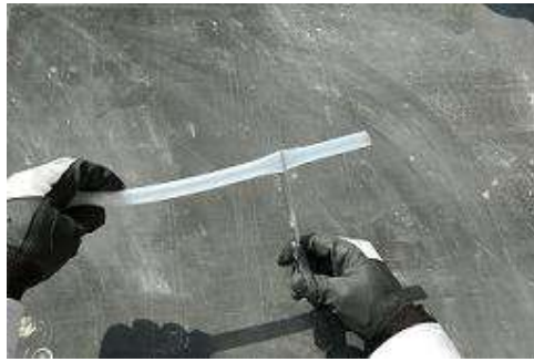
写真 4-6 注入ノズルのカット
