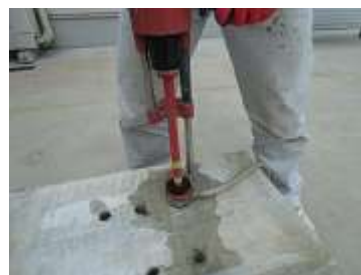
写真 4-2 穿孔(コアドリル)
