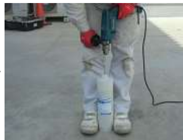
写真 4-12 本混合 (上から順に、セメフォースアンカー150、500、1200)
