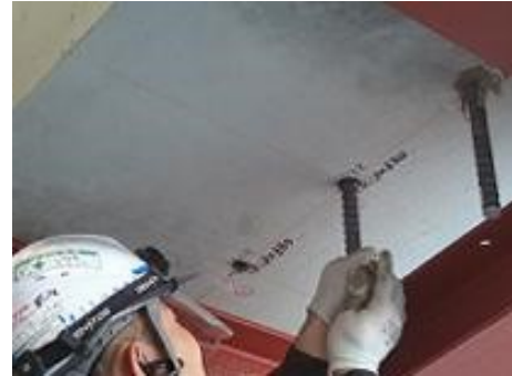
上向きアンカー筋挿入
