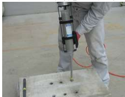
写真 4-20 カートリッジの取り付け
