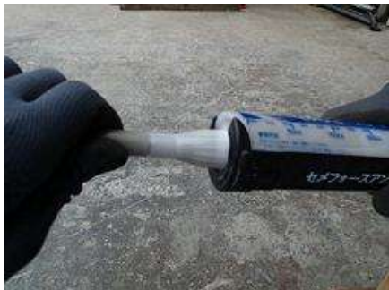
写真 4-24 カートリッジ、ノズルの交換
