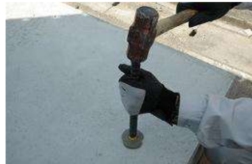
写真 4-23 アンカー筋の埋め込み
