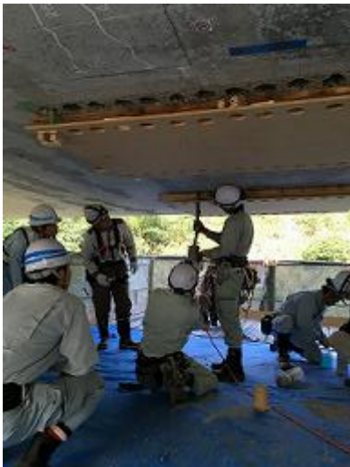
エアガンによる上向き注入状況
